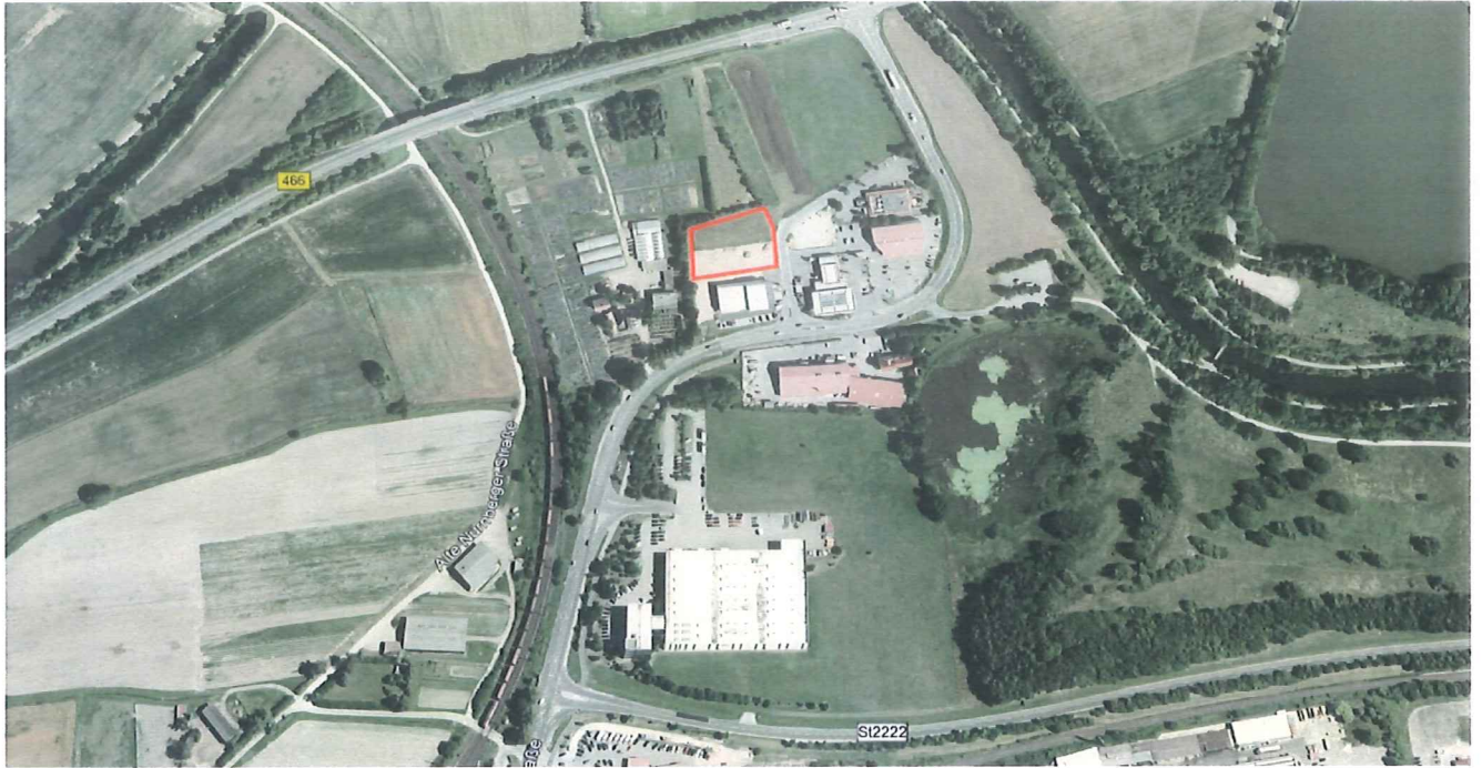
Abbildung 1: Luftbild des jetzigen Zustandes mit Umfeld
