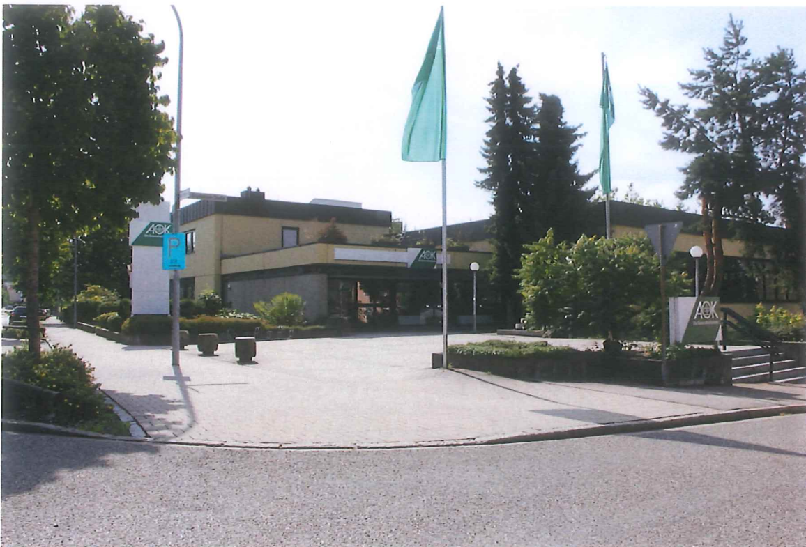
Abbildung 1: Blick von Nordwesten/ Albert-Schweitzer-Straße auf das Bestandsgebäude
