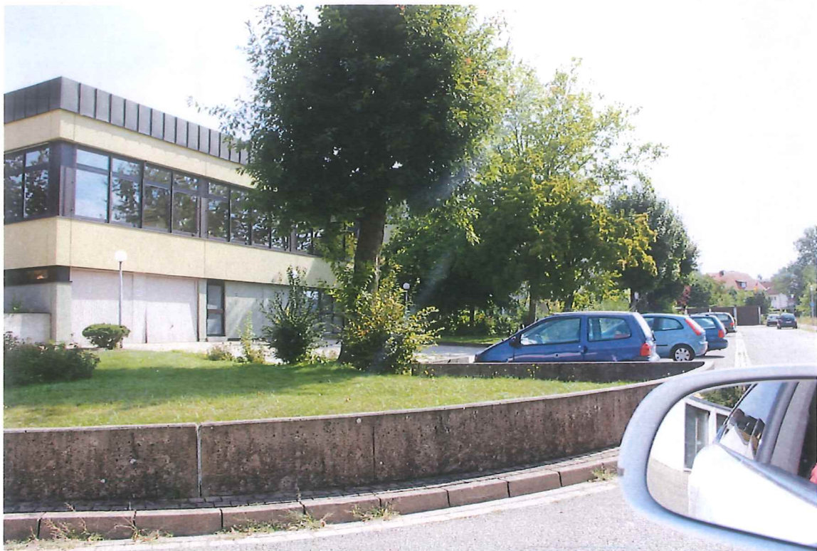
Abbildung 3: Blick auf das Bestandsgebäude und in die Elsa-Brandström-Straße
