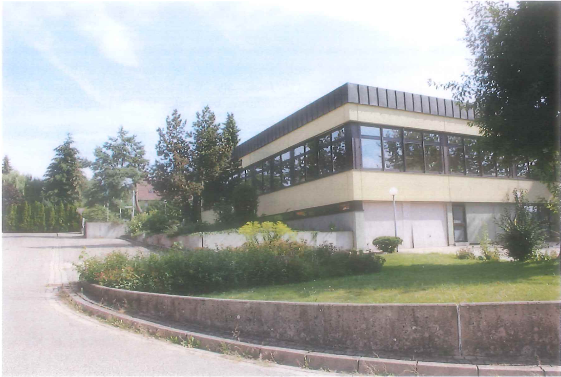
Abbildung 2: Blick von Südwesten auf das Bestandsgebäude
